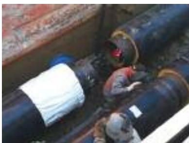
*Ce projet phare pour la Métropole, constitue une réponse innovante aux enjeux de la transition énergétique. Il représente la pose de 2 canalisations calorifugées (aller-retour) sur un linéaire de 20 kilomètres, en milieu urbain essentiellement. Ce réseau, l’un des plus longs réseaux de transport d’énergie mis en service en France, sera complètement opérationnel pour fin 2020.*
